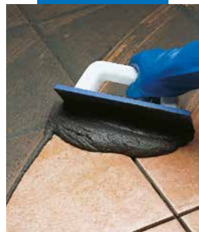
Afvoegen van enkelgebakken tegels met een spaan
