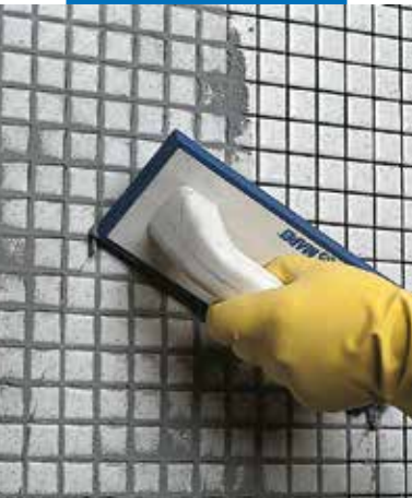
Afvoegen van glasmosaïek (badkamer) met een spaan
