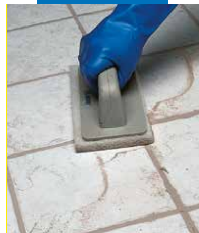
Afwerking met Scotch-Brite®
