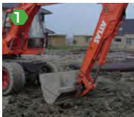
1 de graafwerken uitvoeren
