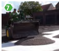
7 plaatsen van het grind
