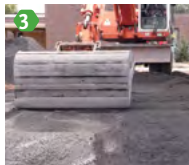
3 verdichten met trilplaat
