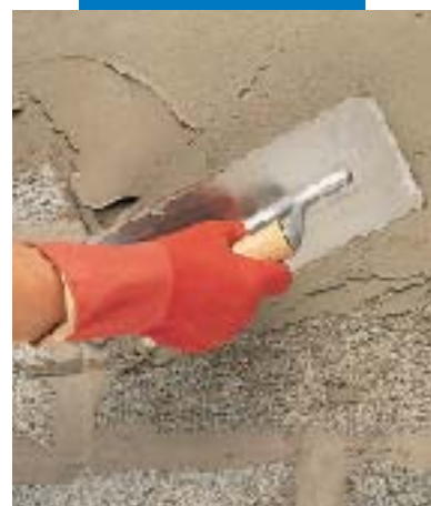
Het met een spaan aanbrengen van Idrosilex Pronto
