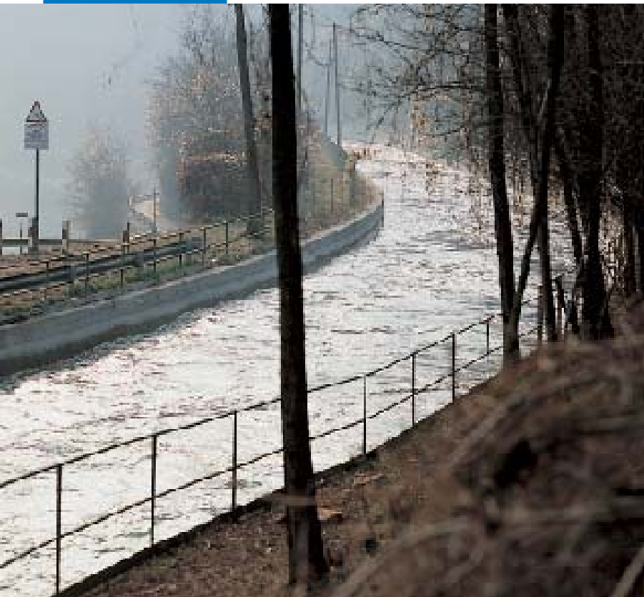
Het Bertini-kanaal voor hydro-elektrische energieopwekking in Robbiate (Italië), waarvan het oppervlak is behandeld met Idrosilex Pronto
