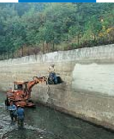
Idrosilex Pronto wordt in een kanaal voor hydro-elektrische energieopwekking gespoten
