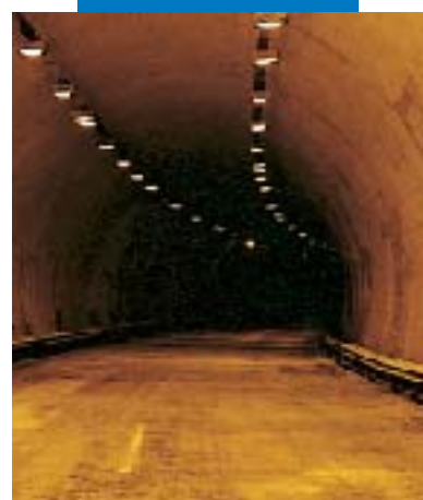
Het in een verkeerstunnel opspuiten van Idrosilex Pronto wit
