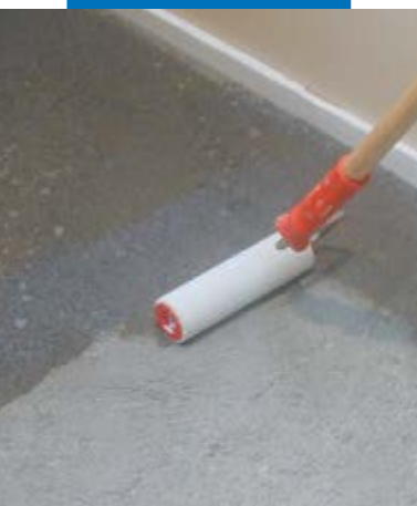
Primer G aanbrengen met een roller
